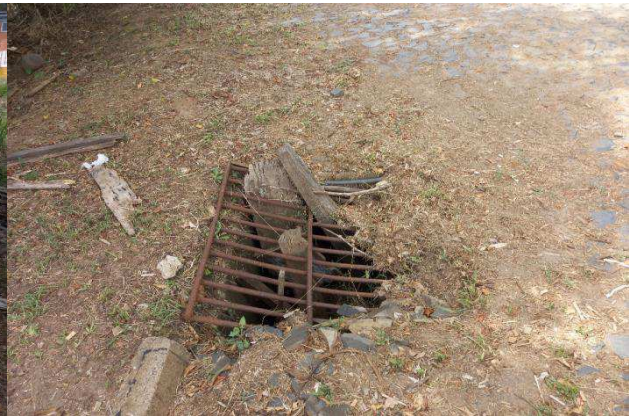
Boca de lobo para captação de águas pluviais
