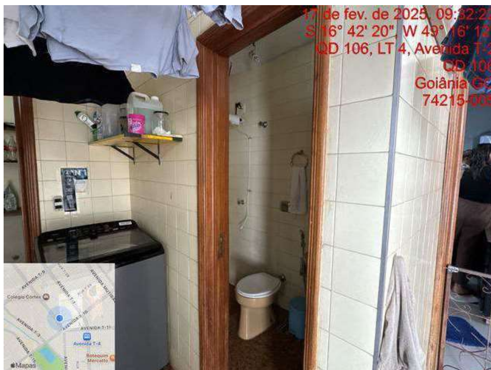
Foto 15 – Vista WC Area de Serviço – Avenida T-2, Quadra 106 Lote 03/07
