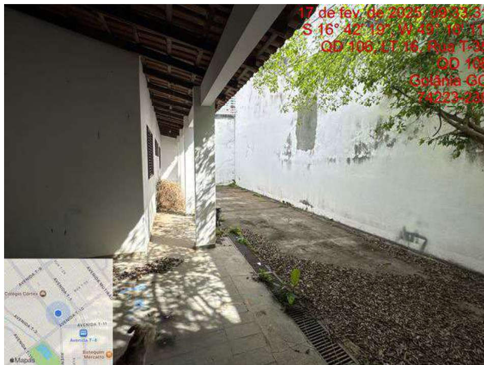
Foto 31 – Vista Fundos – Avenida T-2, Quadra 106 Lote 03/07
