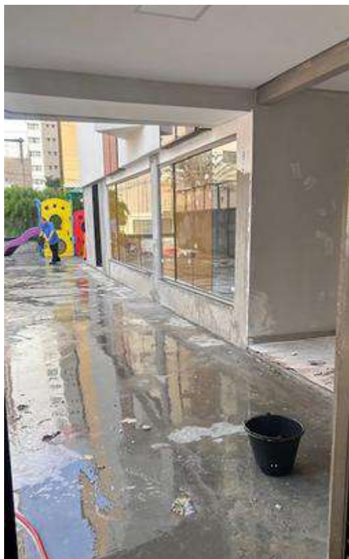
Academia em construção
