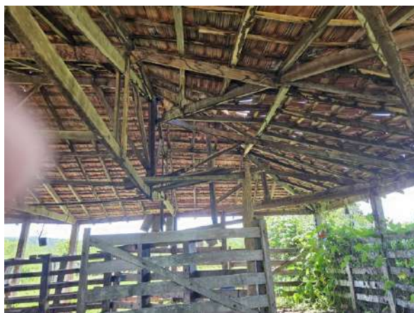
Foto 30-Curral – vigas danificadas por cupins
