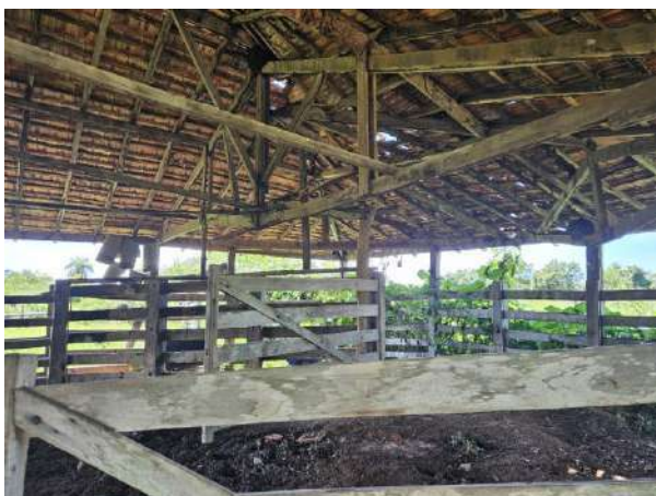
Foto 29- Curral– telhado com vigas danificadas por cupins
