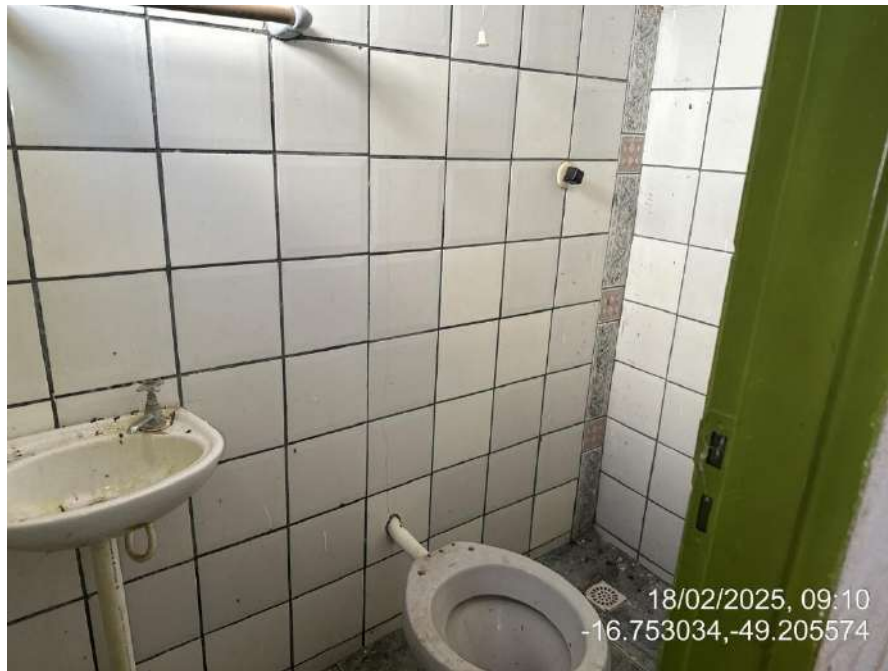
Banheiro da Sala 1
