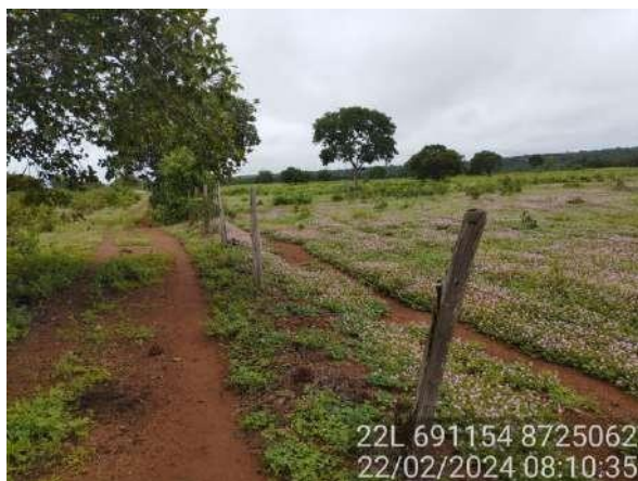
Foto 2: Cerca estado ruim de conservação
