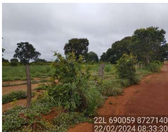
Foto 7: Cerca estado ruim de conservação
