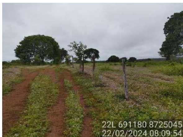
Foto 3: Cerca estado ruim de conservação
