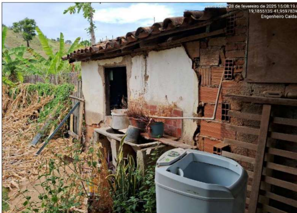
Imagem 20: Fundos da casa sede principal do terreno.
