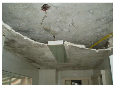
Lavanderia piso térreo
