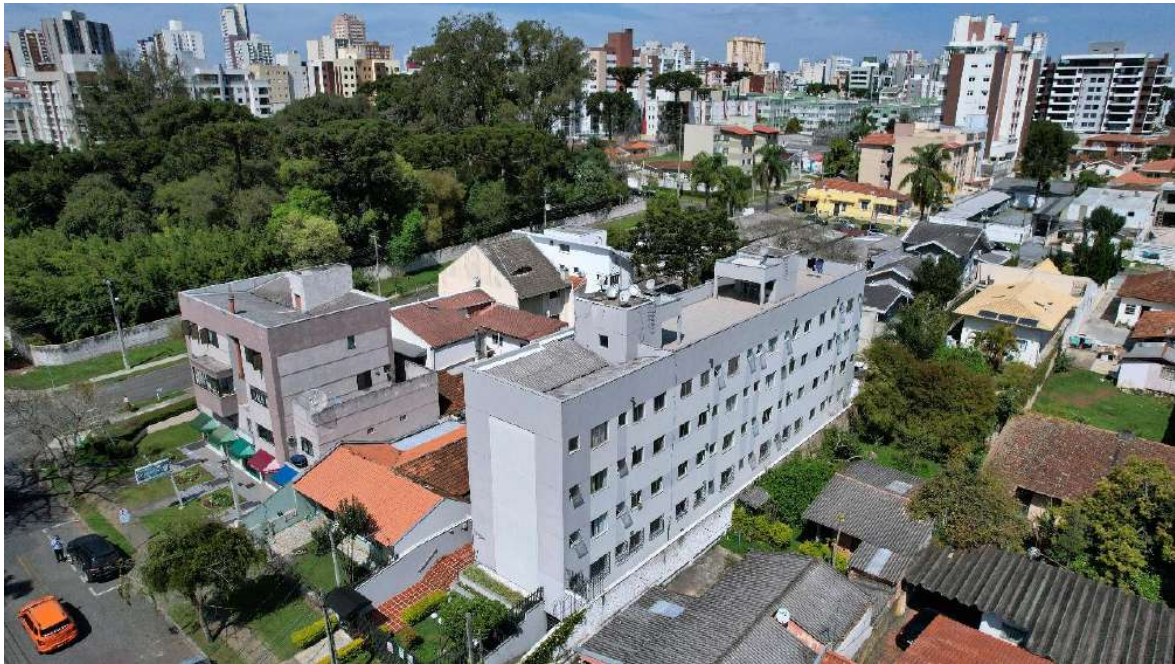
VISTA ÁEREA DO IMÓVEL
