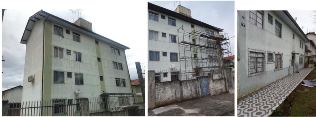
3 IMAGENS QUE TRAZEM A VISTA DA FACHADA DO IMÓVEL, COM CARACTERÍSTICAS E PADRÃO.
