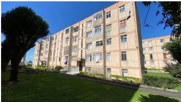
VISTA DA FACHADA DO BLOCO 3
