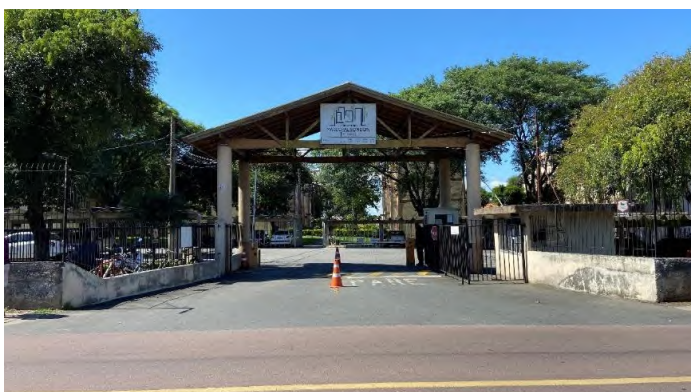
VISTA FACHADA DO CONDOMÍNIO
