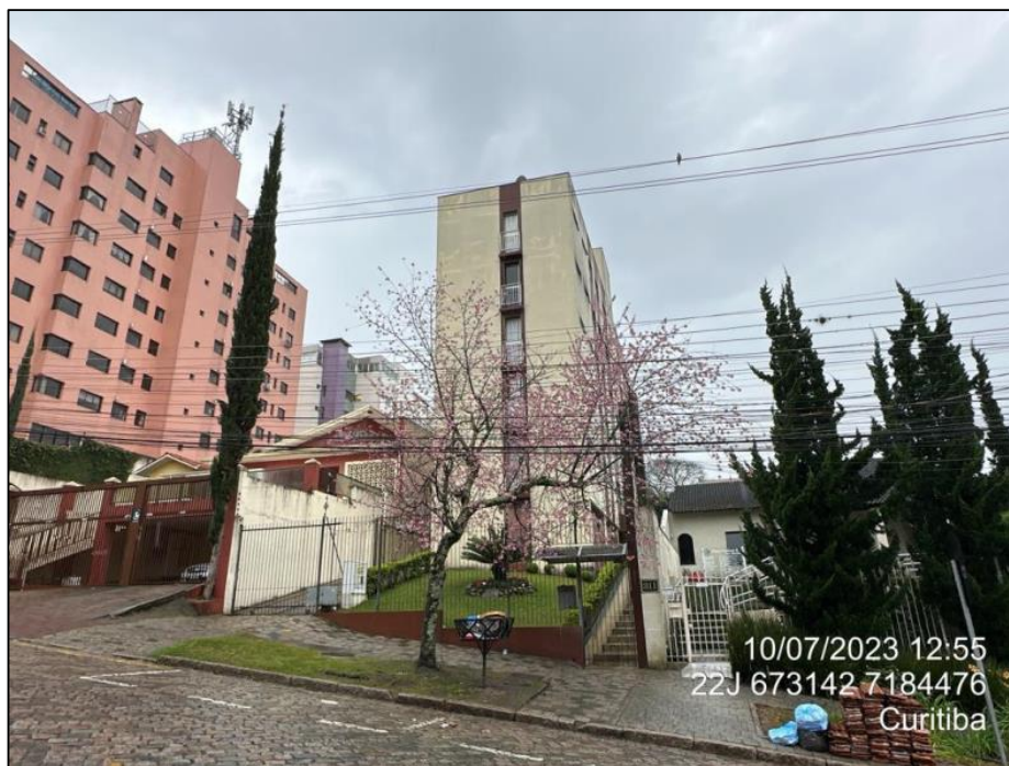
FIGURA 1 – Vista frontal do Edifício Curupira
