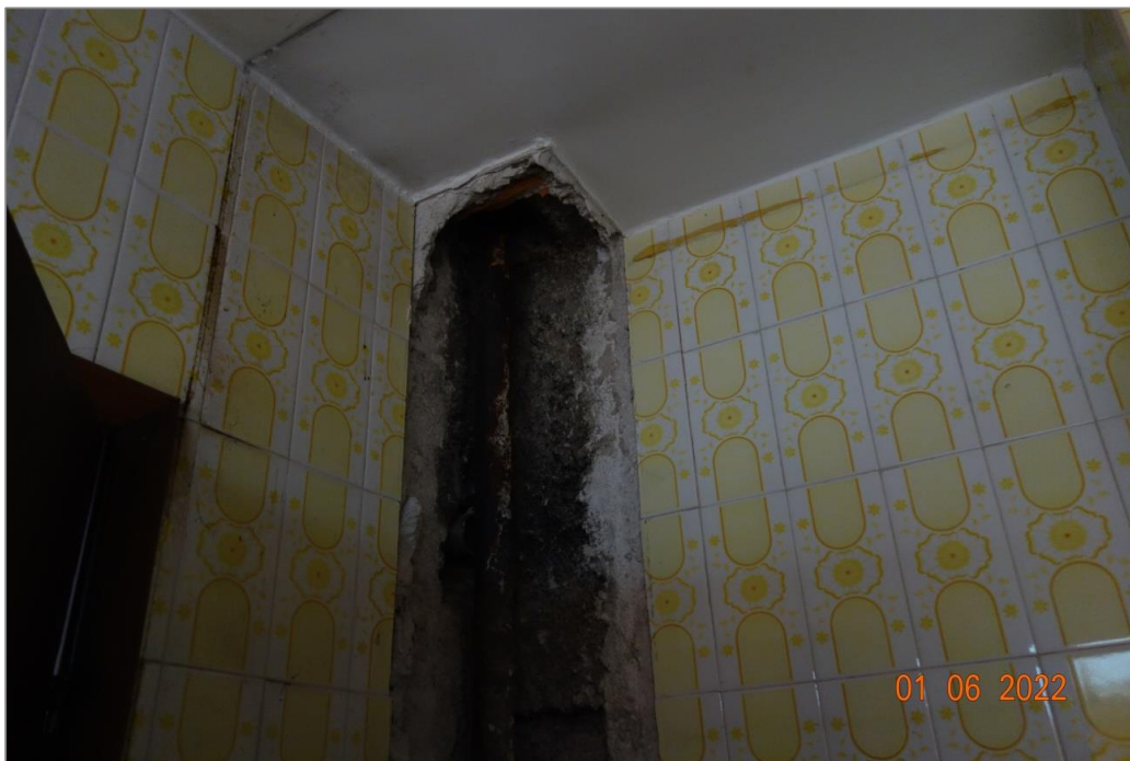
FIGURA 5 – Estado de conservação da cozinha
