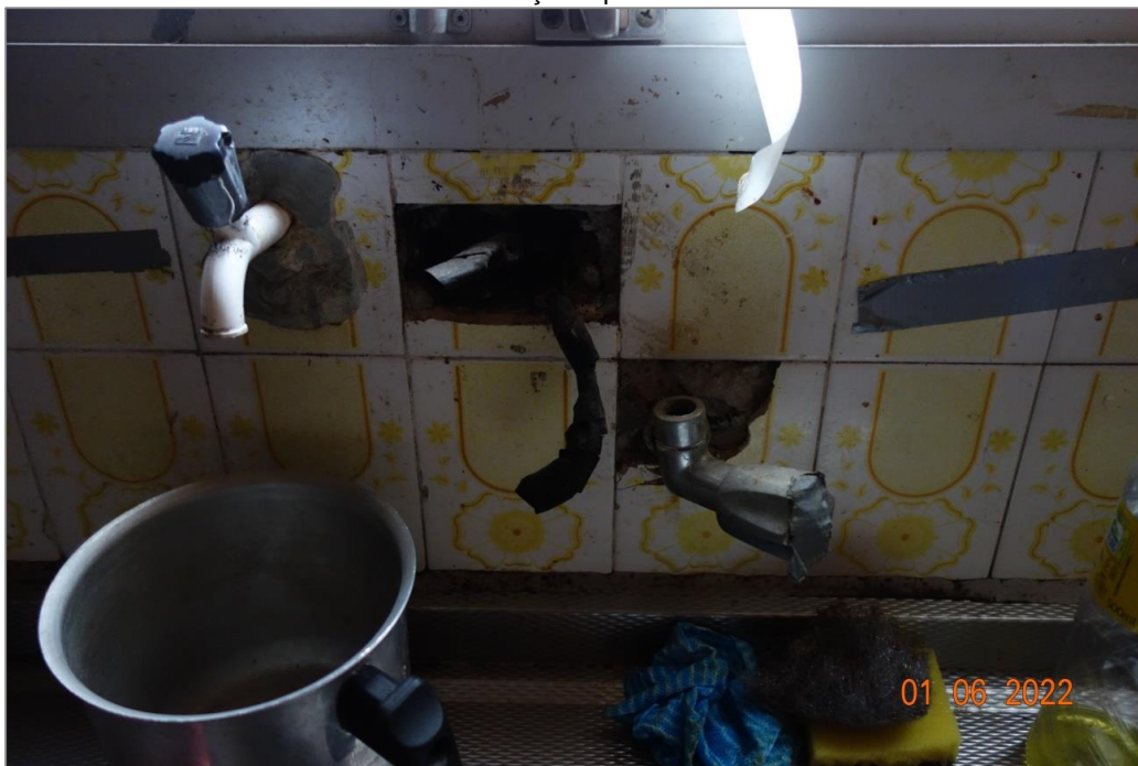
FIGURA 6 – Estado de conservação e padrão de acabamento da cozinha
