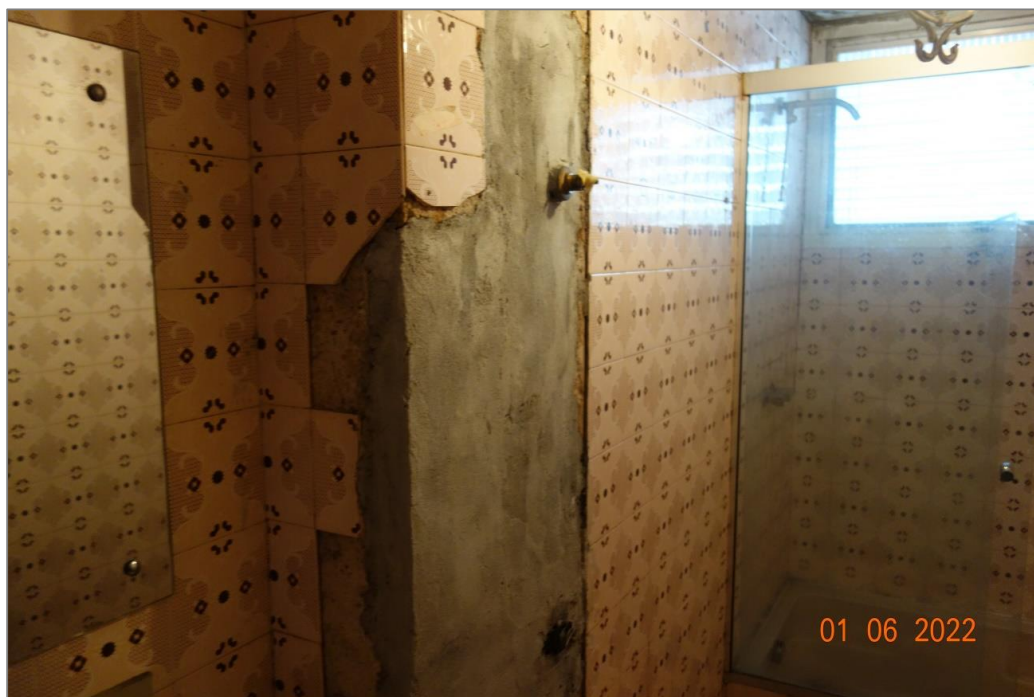
FIGURA 7 – D Estado de conservação e padrão de acabamento do banheiro
