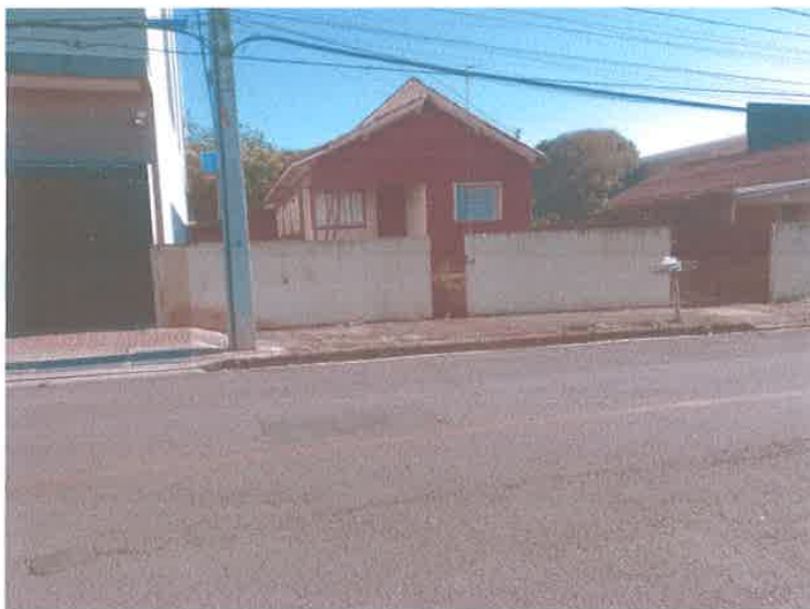
Foto 01 - Vista frontal do terreno onde consta um edifício de 04 (quatro) pavimentos ao lado do imóvel
