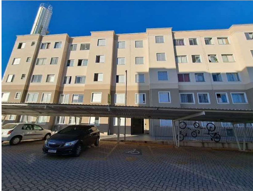
Foto 7 – Fachada do Bloco 2
