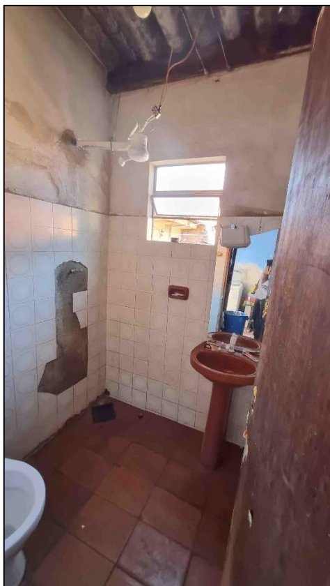
Imagem 37: Banheiro com infiltrações, falta de acabamentos e tubulação aparente.
