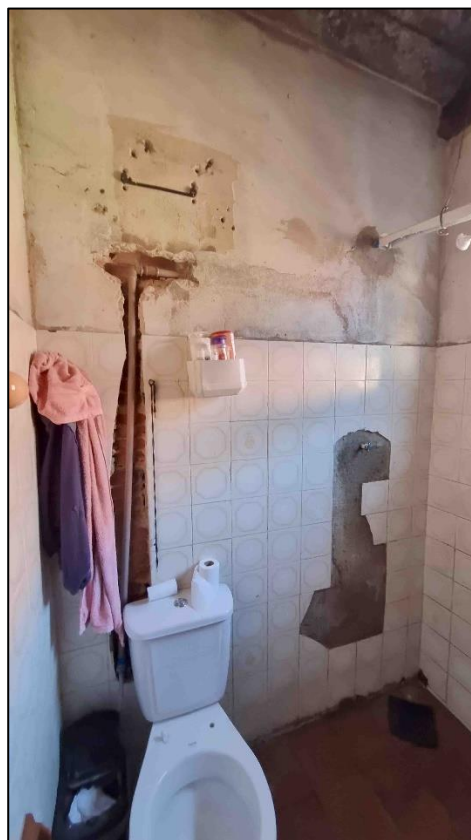
Imagem 37: Banheiro com infiltrações, falta de acabamentos e tubulação aparente.
