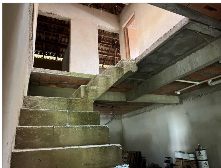
Foto 6 – Vista parcial do piso superior
