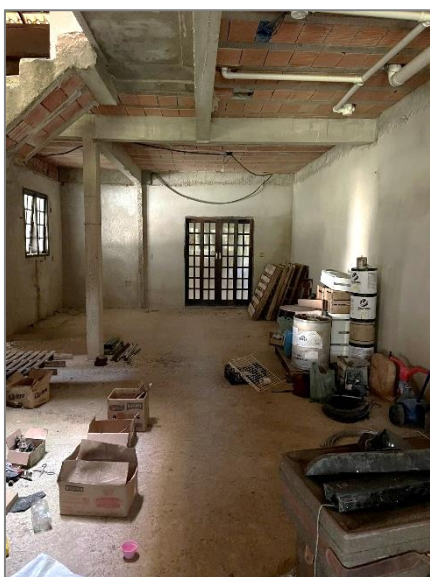
Foto 5 – Vista do piso térreo
