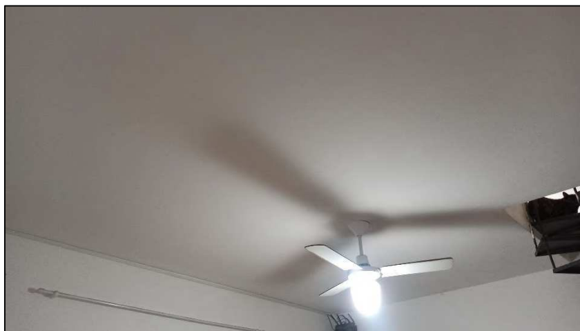
Foto 12. Sala da residência dos fundos
