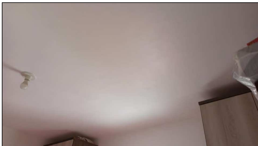
Foto 15. Dormitório 1 da residência dos fundos
