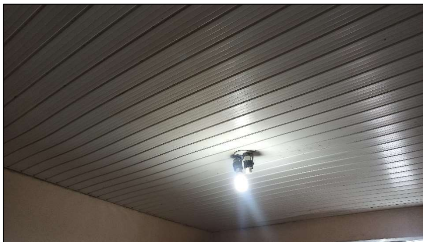
Foto 48. Dormitório 3 da residência principal
