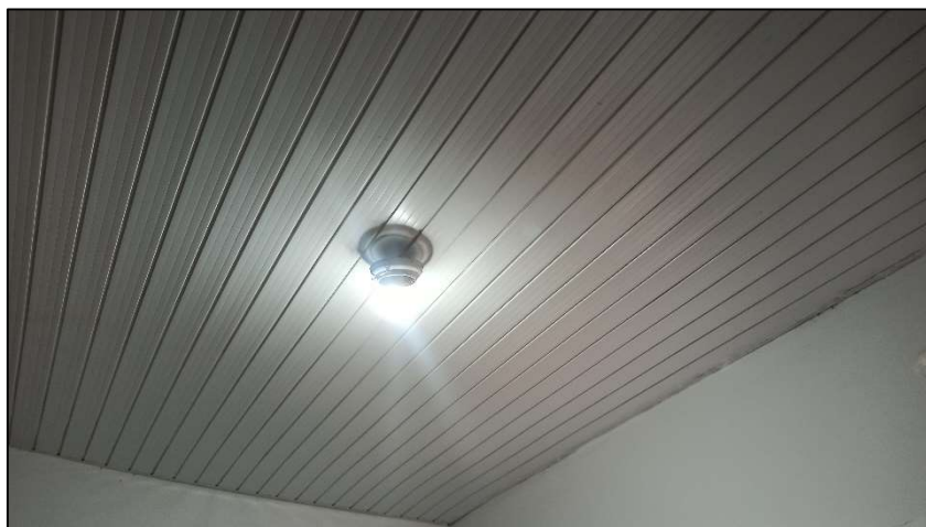
Foto 39. Dormitório 1 da residência principal
