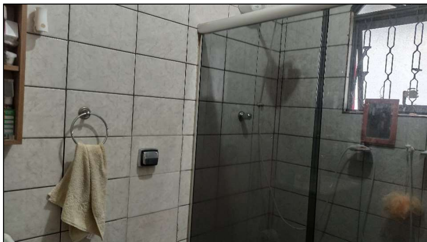
Foto 25. Banheiro da residência dos fundos
