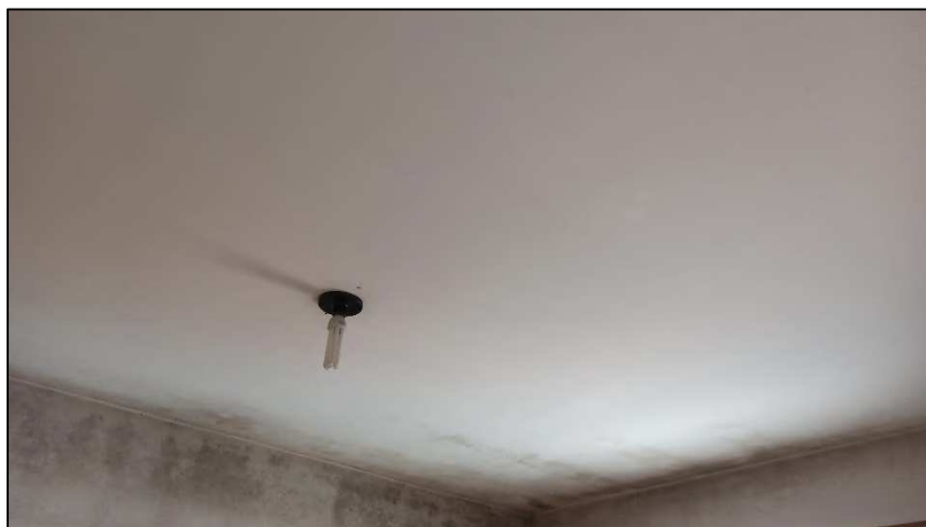
Foto 21. Dormitório 2 da residência dos fundos
