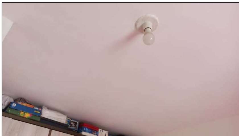
Foto 18. Dormitório 1 da residência dos fundos
