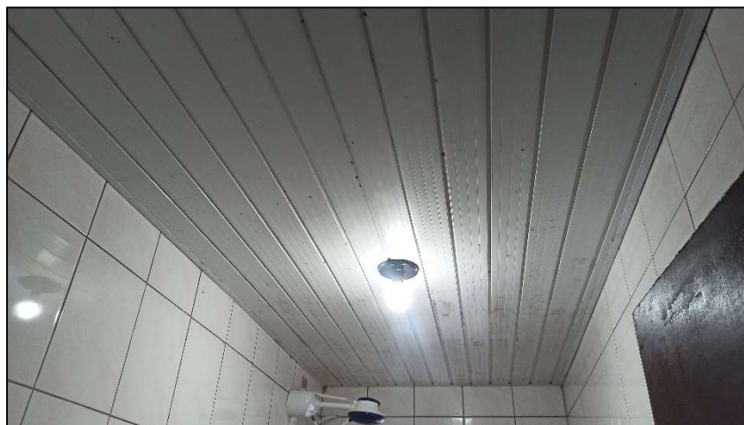
Foto 36. Banheiro 1 da residência principal
