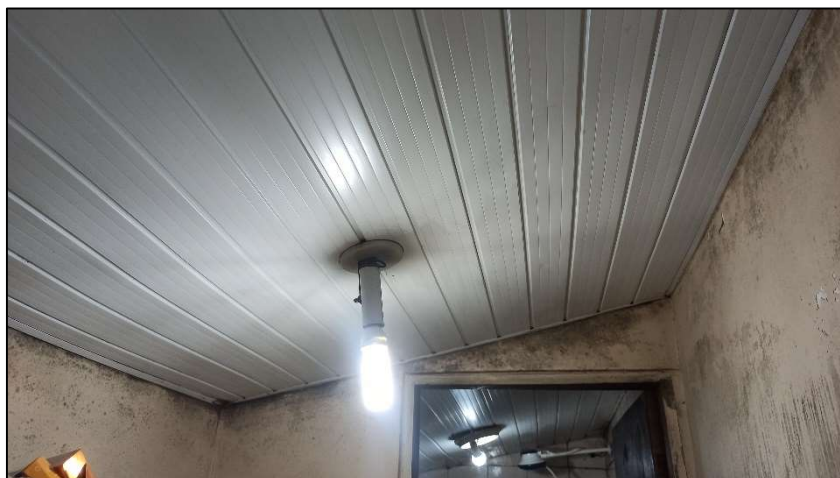
Foto 51. Acesso ao banheiro 2 da residência principal
