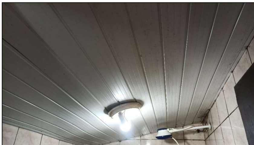
Foto 54. Banheiro 2 da residência principal
