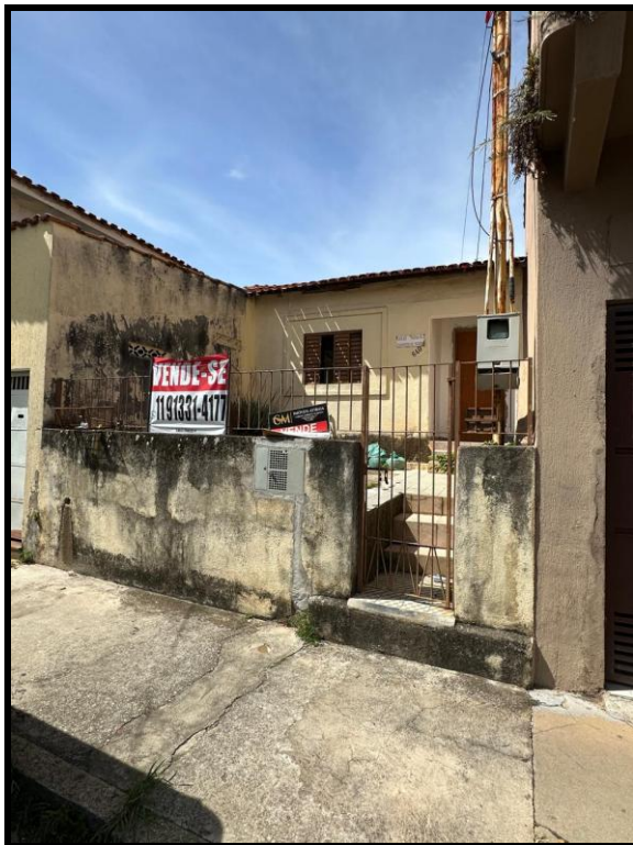
VISTA FRONTAL DO IMÓVEL AVALIANDO
