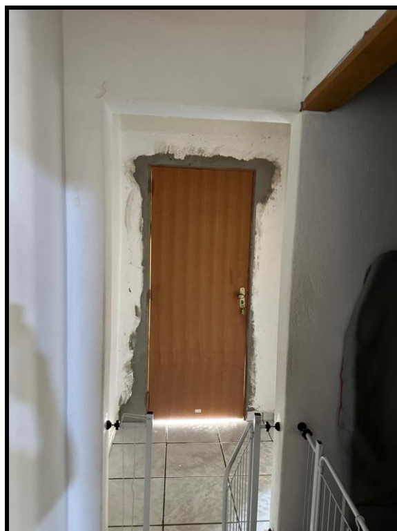
VISTA INTERNA DO IMÓVEL AVALIANDO
