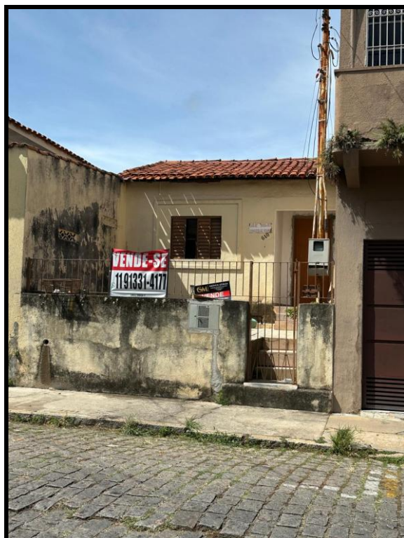
VISTA FRONTAL DO IMÓVEL AVALIANDO
