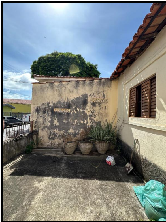
VISTA INTERNA DO IMÓVEL AVALIANDO
