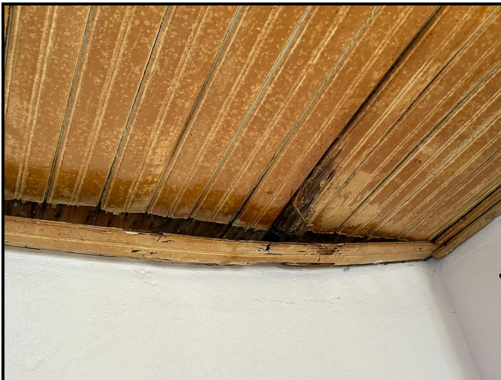
VISTA INTERNA DO IMÓVEL AVALIANDO
