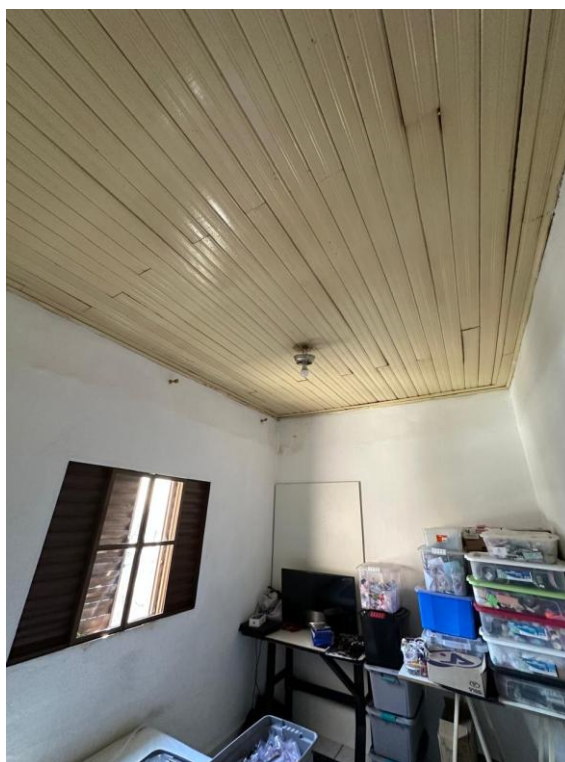
VISTA INTERNA DO IMÓVEL AVALIANDO
