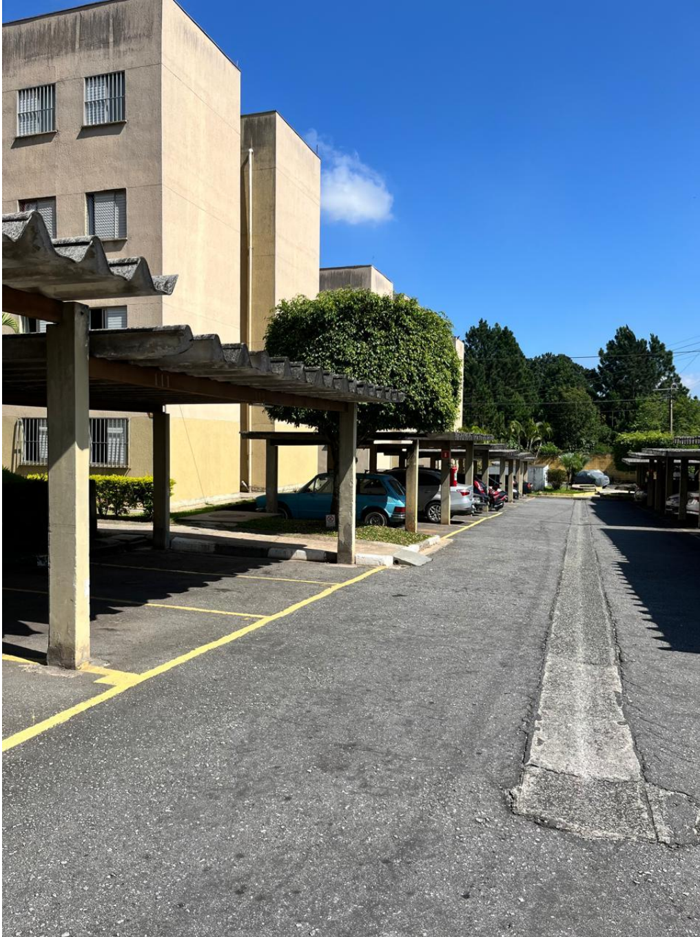
Fachada do edifício Peru - Bloco 24 e garagens
