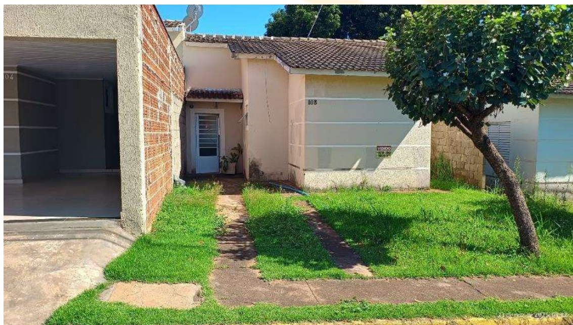
Fachada da edificação. Muros de divisa em alvenarias aparentes.
