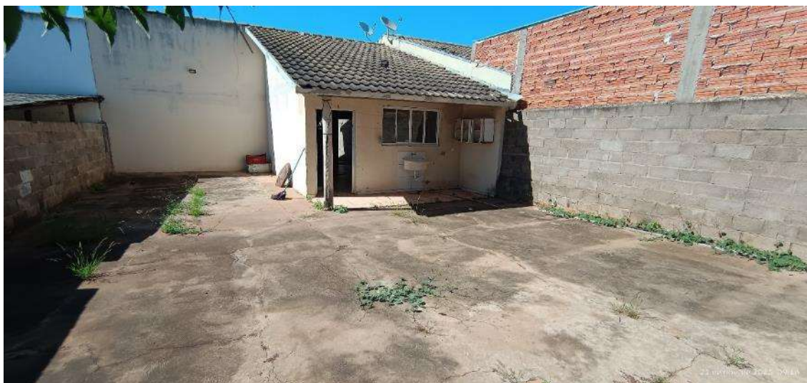
Vista do fundo. Muros e piso sem acabamento. A casa está mal conservada, com manchas de biofilme em pisos e paredes.
