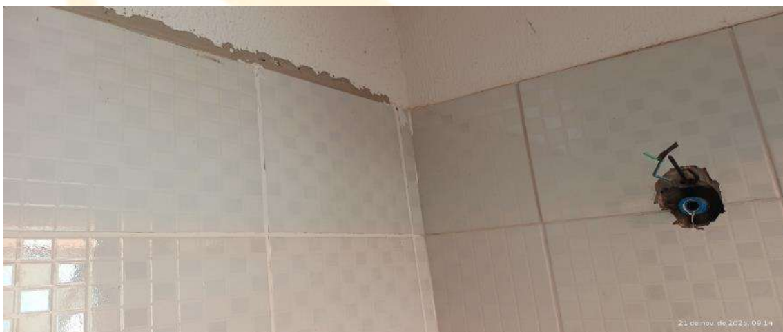
Detalhe do assentamento cerâmico e instalação elétrica junto com instalação hidráulica (fora de norma).
