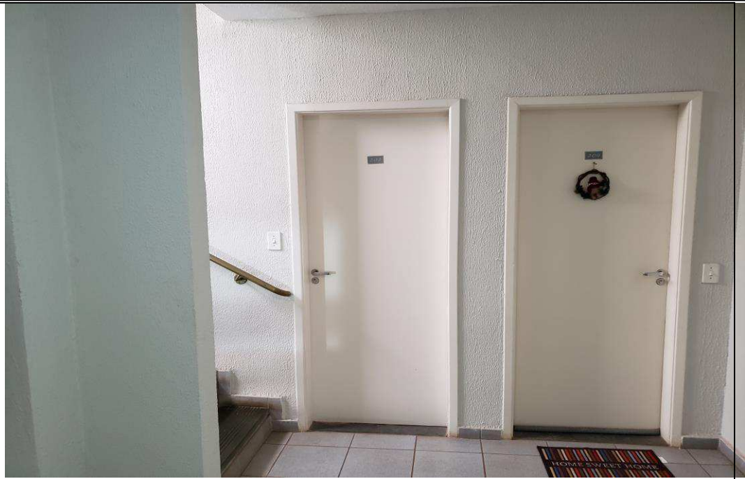
FOTO 03 – Vista da porta frontal do apartamento (nº203).
