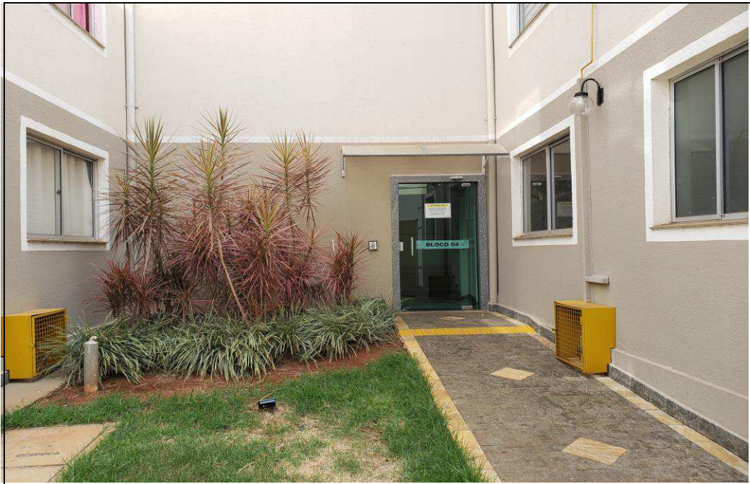
FOTO 02 – Vista frontal do bloco 04.
