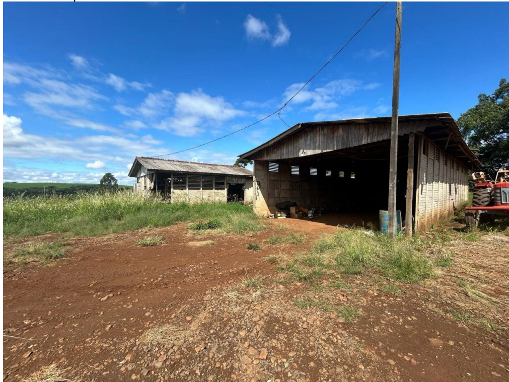
Foto 7 – Vista parcial dos barracões rústicos
