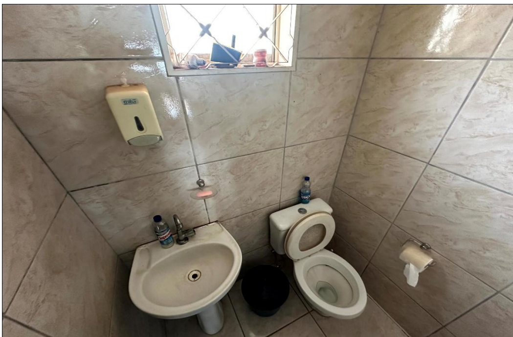
FOTO 04 – Vista geral do banheiro da barbearia.
