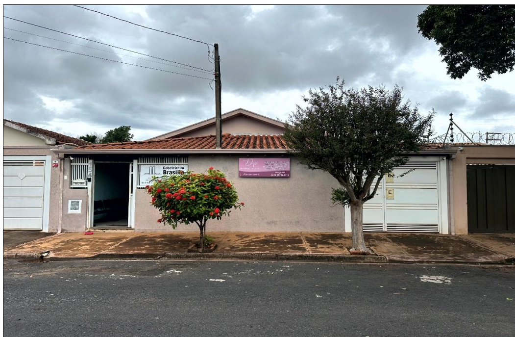
FOTO 01 – Vista geral da fachada dos imóveis nº154/150.
