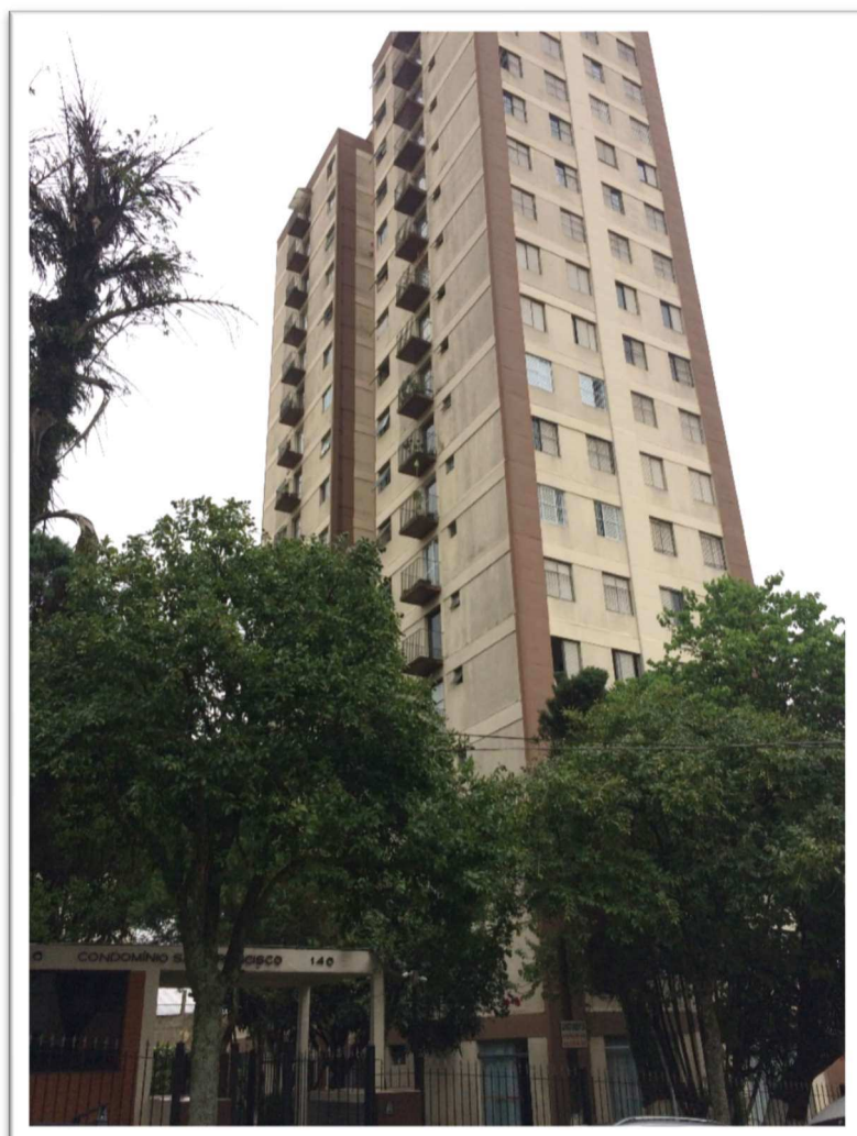
FACHADA DO PRÉDIO DO IMÓVEL AVALIANDO
