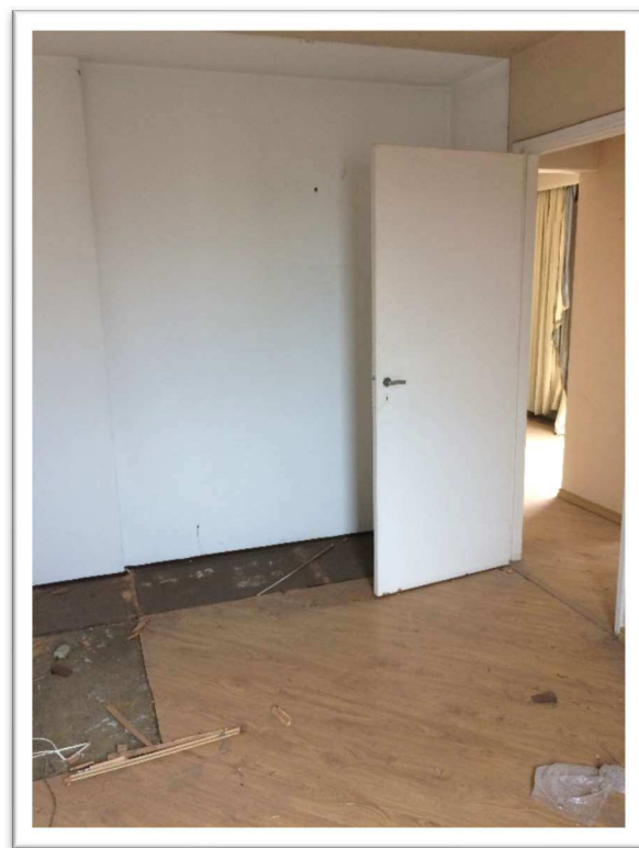
FOTO 10 – Dormitório 2 do imóvel avaliando
