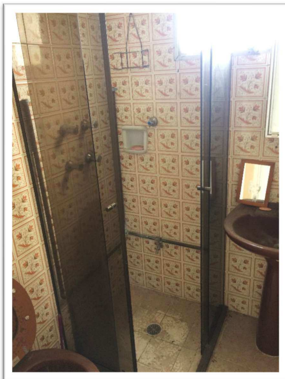
FOTO 11 – Banheiro do imóvel avaliando
