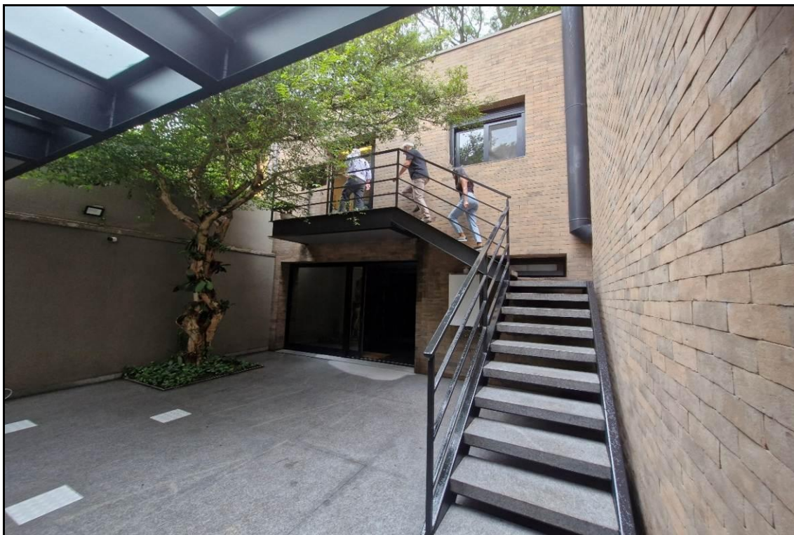
Foto nº 41: Vista da segunda edícula existente nos fundos do imóvel.
