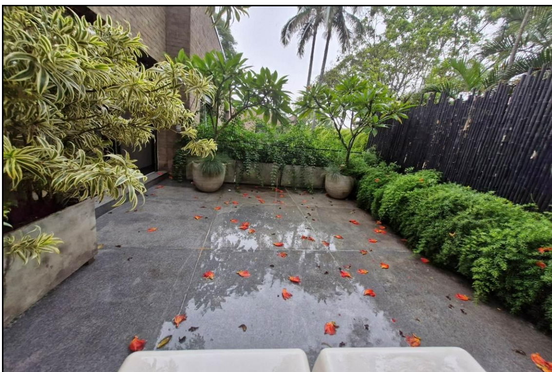
Foto nº 30: Detalhe da sacada acessada pelo dormitório retratado na foto anterior.
