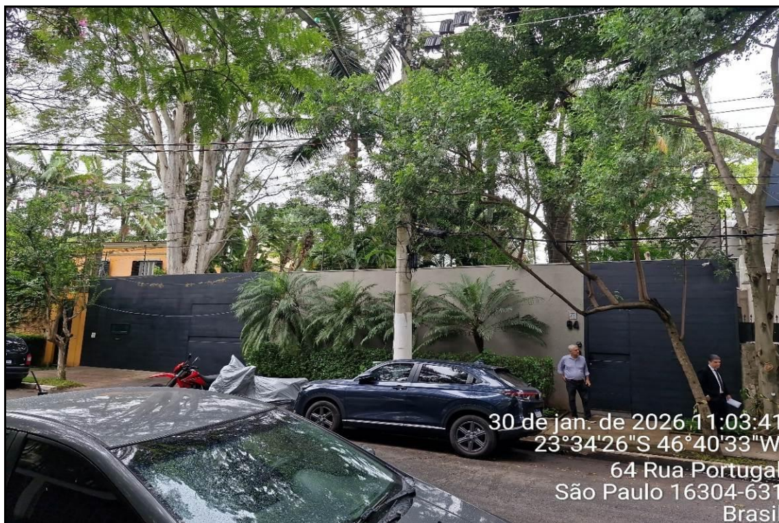
Foto nº 3: Vista da fachada do imóvel sob nº 64 da Rua Portugal.
