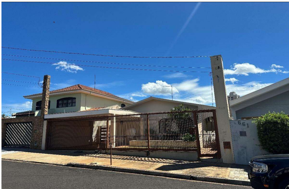
FOTO 01 – Vista frontal do imóvel situado na Rua Dr. Walter Medeiros Mauro nº 649 – Vila Harmonia
