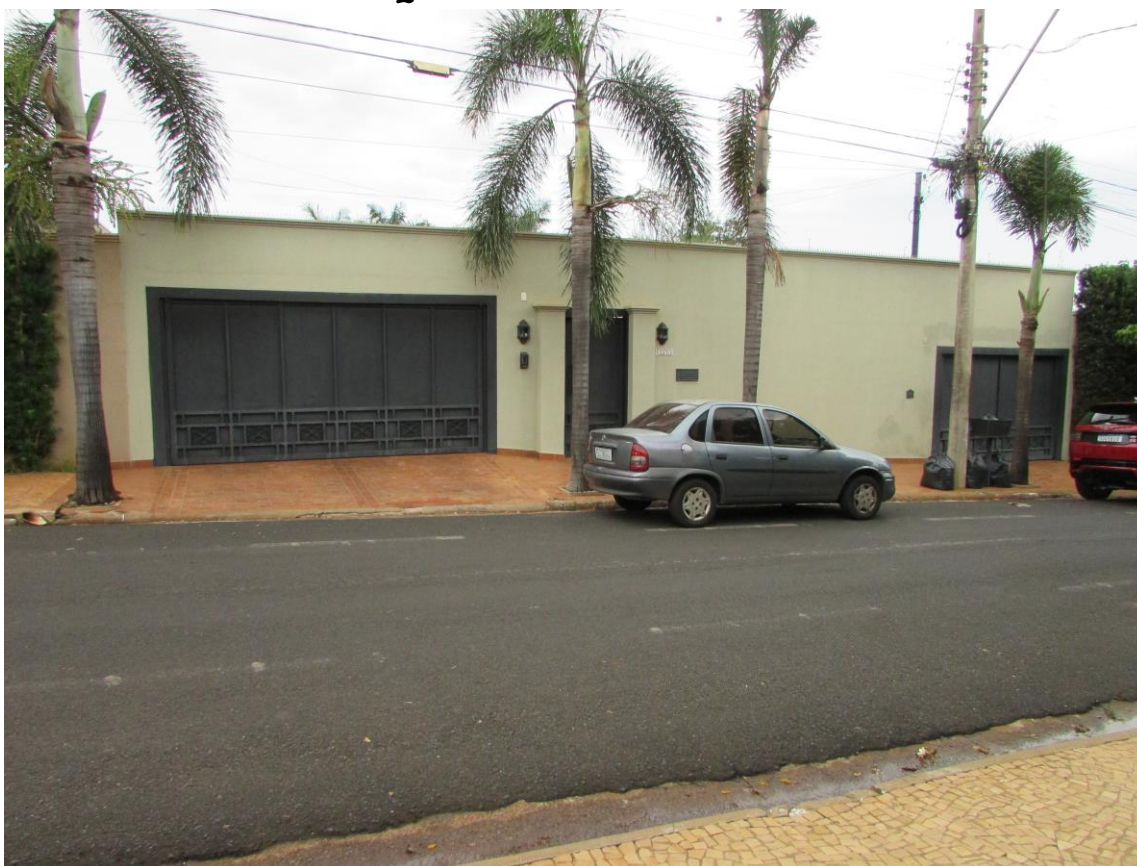
Vista da face frontal da residência voltada para a Avenida 39.
