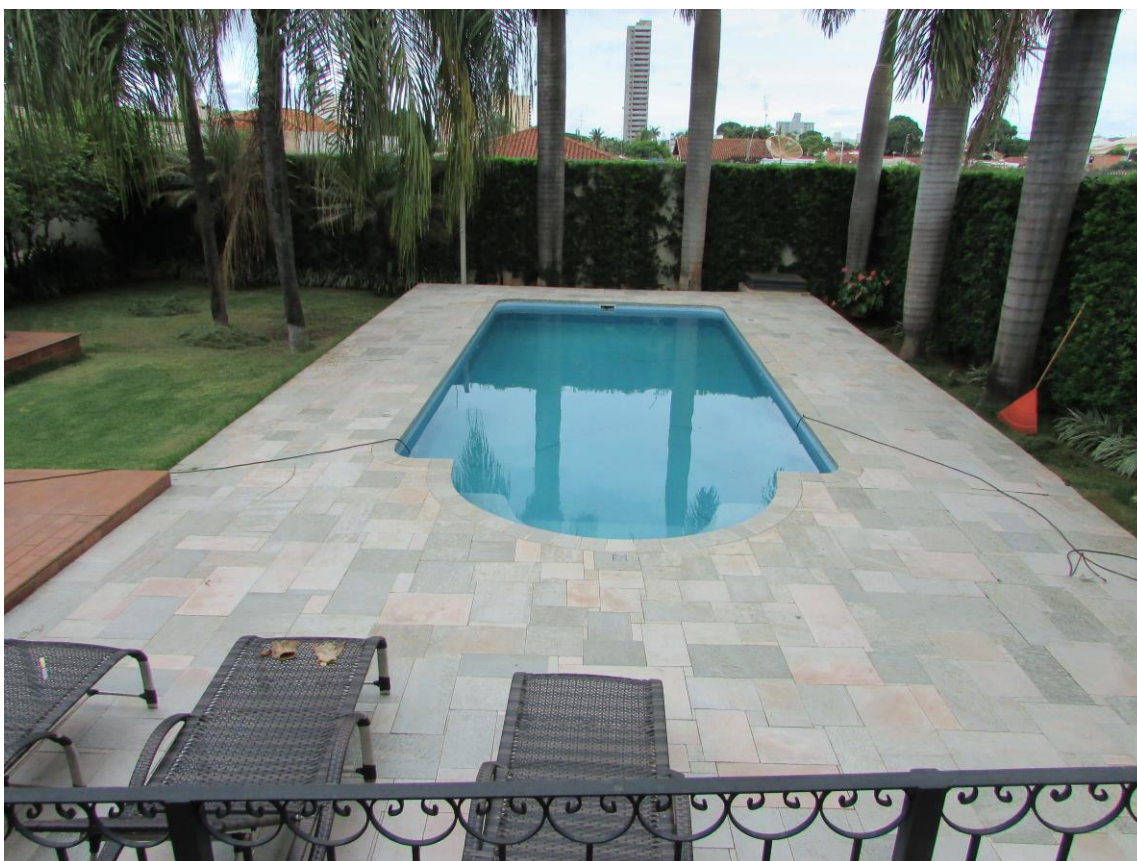
Vista da piscina revestida com manta vinílica e solário de pedra Goiana serrada.
