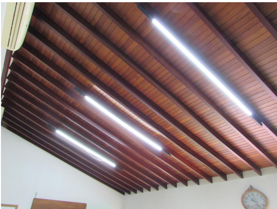
Vista do forro de madeira da varanda voltada para piscina, anexa à cozinha.
