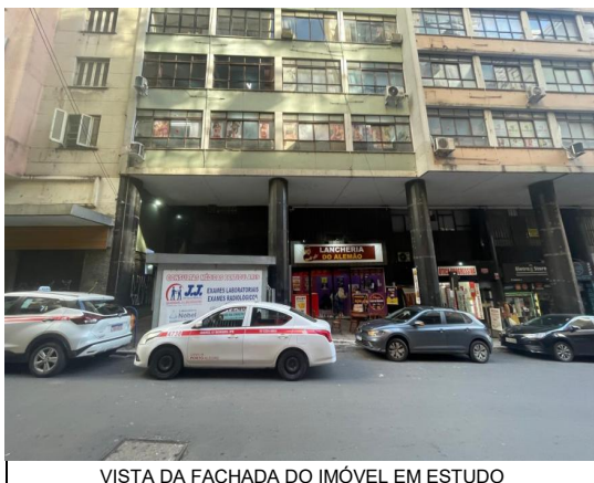
VISTA DA FACHADA DO IMÓVEL EM ESTUDO
