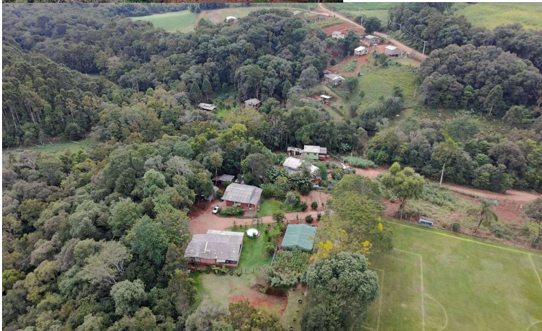
VISÃO GERAL COM DUAS RUAS DE ACESSO AO IMÓVEL
