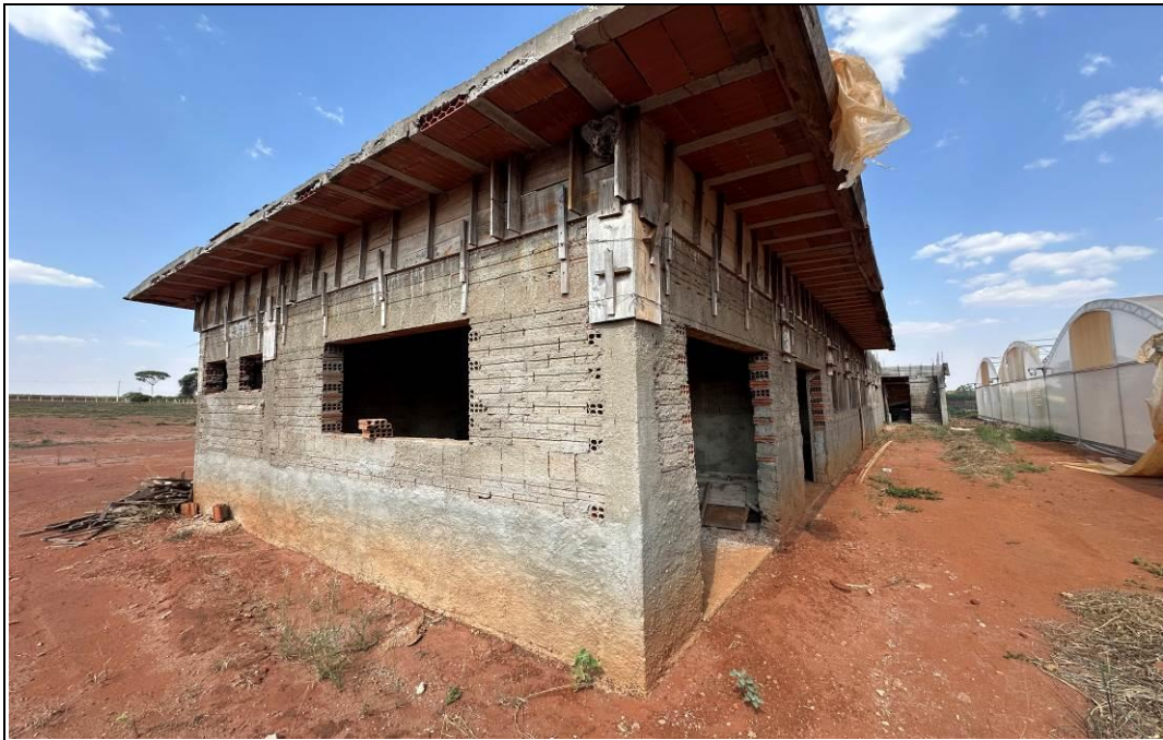
FOTO 02 – Vista parcial externa da edificação inacabada.
