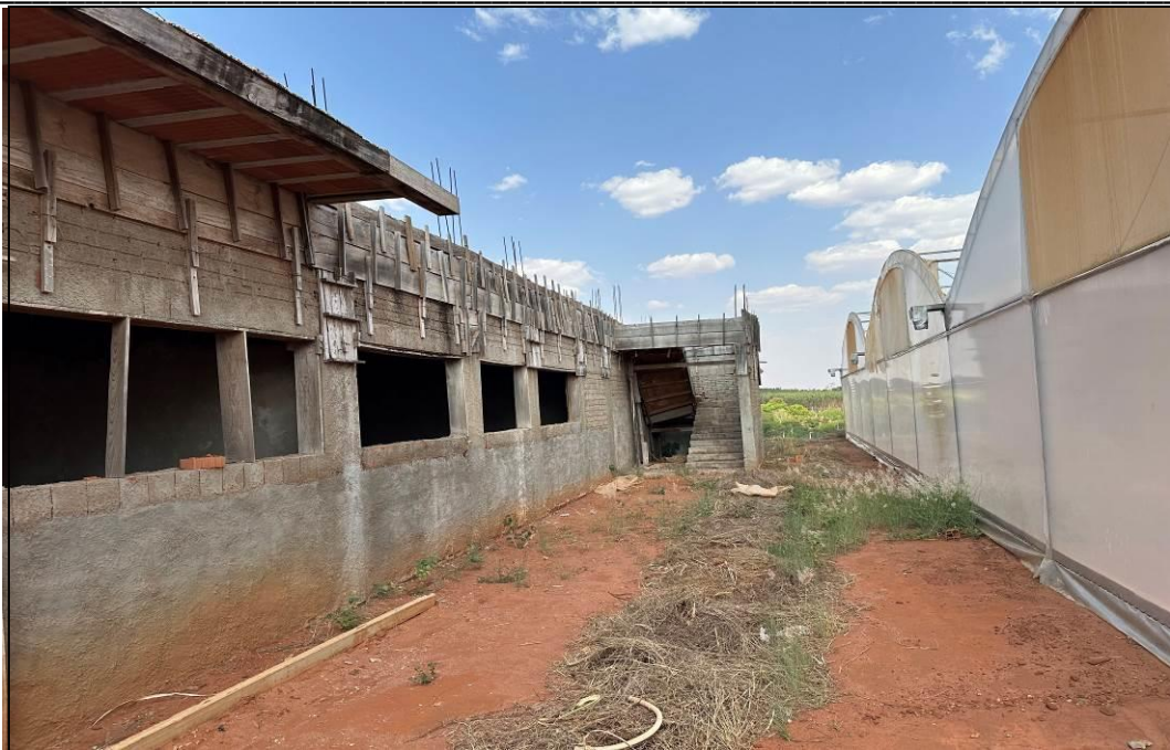
FOTO 07 – Vista parcial externa da edificação inacabada.
