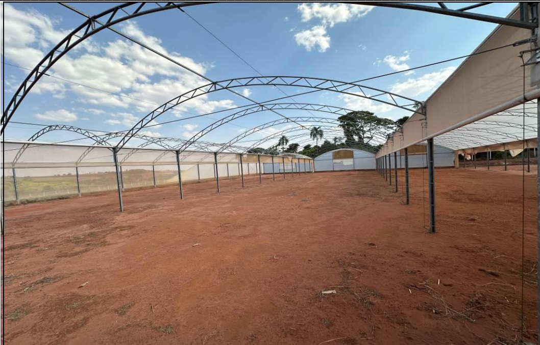
FOTO 12 – Vista parcial das estruturas de estufas agrícolas.
