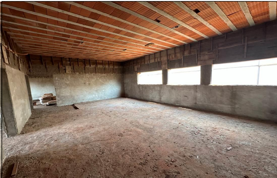
FOTO 04 – Vista parcial interna da edificação inacabada.
