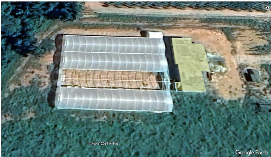
Imagem de satélite retirada do Google Earth para obter as medidas precisas da construção.
