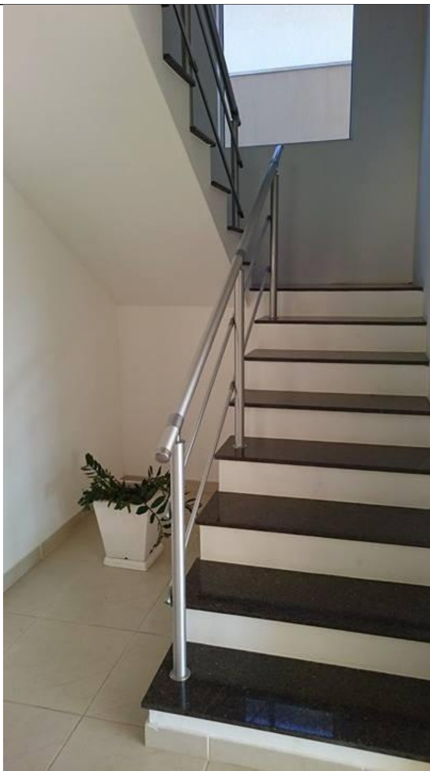
Foto 9: escada de acesso ao piso superior.
