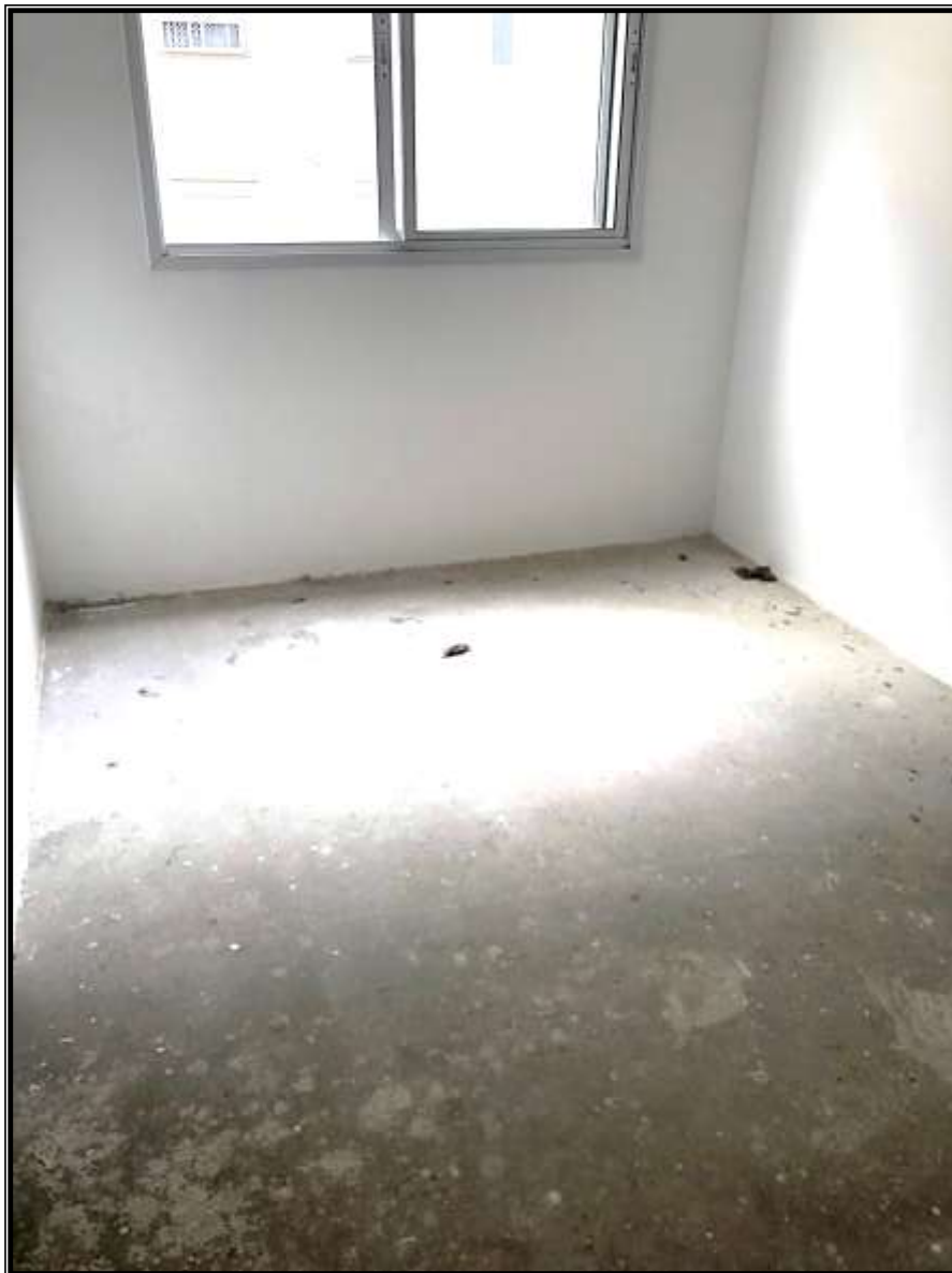
SALA DE ESTAR (piso sem revestimento)
