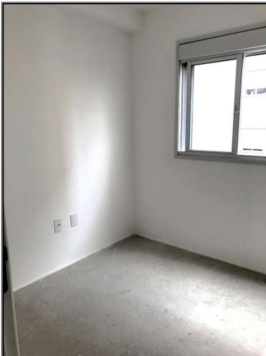
DORMITÓRIO 1 (piso sem revestimento)
