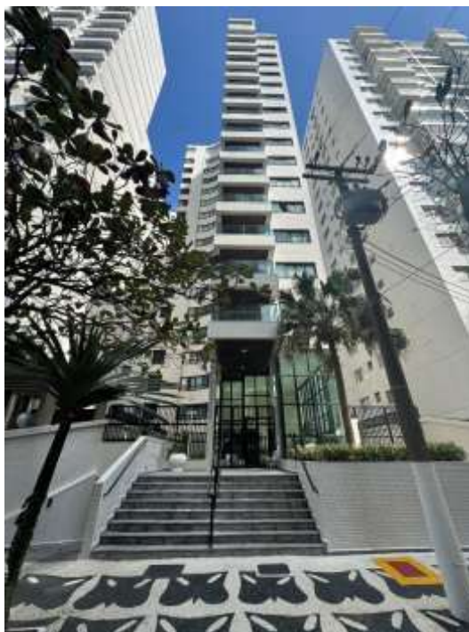
VISTA DO EDIFÍCIO.
