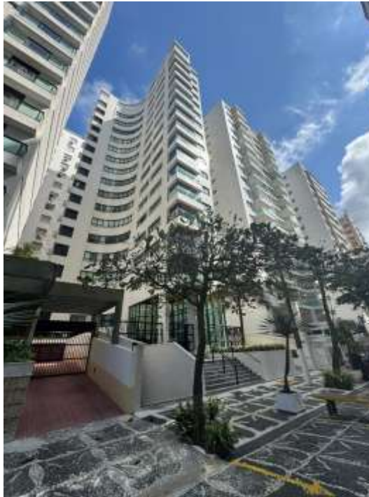
VISTA DA LATERAL DO EDIFÍCIO.
