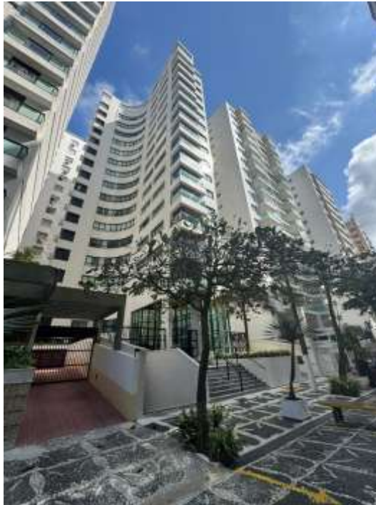
VISTA DA LATERAL DO EDIFÍCIO.
