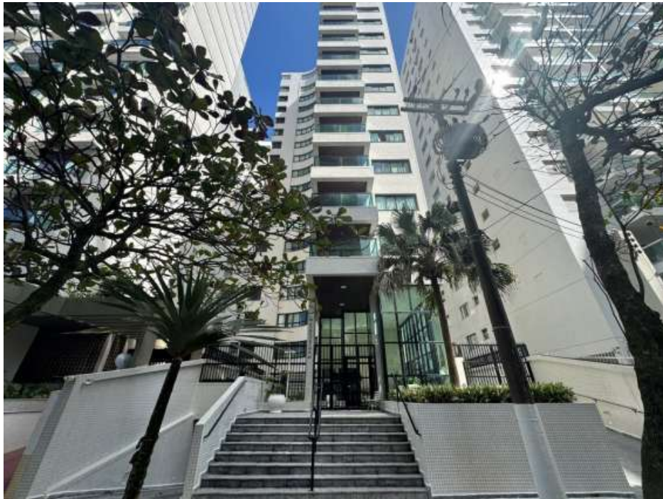
VISTA DA FACHADA DO EDIFÍCIO.
