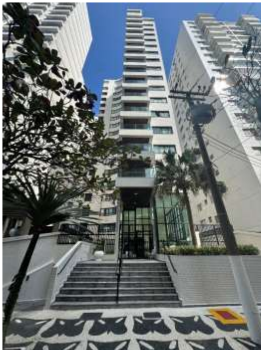
VISTA DO EDIFÍCIO.
