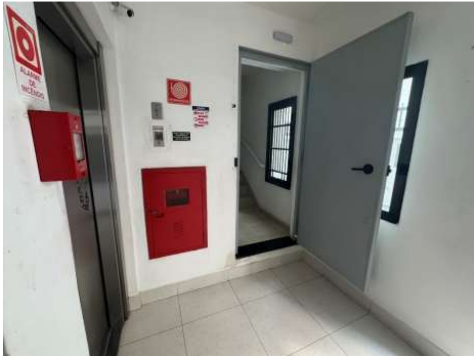
VISTA DO HALL DE SERVIÇO.
