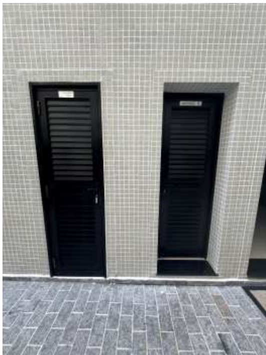
VISTA DO QUADRO DE FORÇA E VESTIÁRIO.
