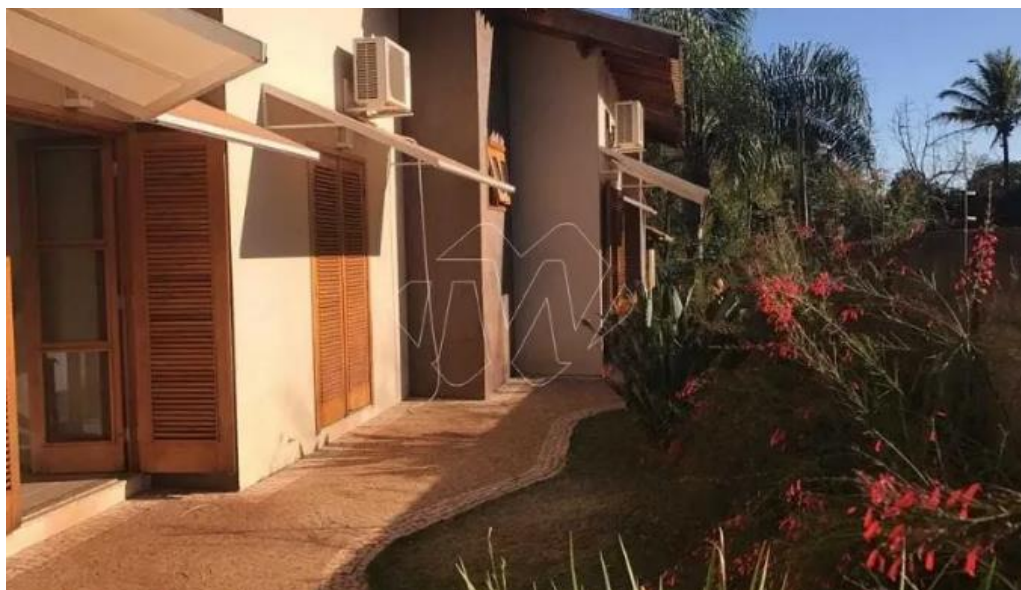
Foto 04 – Vista lateral externa – Piso em pedras assentadas tipo mosaico, pintura em bom estado de conservação, portas, janelas e esquadrias em madeira, paisagismo e gramado em bom estado de conservação.
