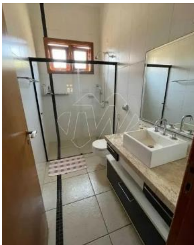
Foto 15 – wc suíte – Piso cerâmico em porcelanato, box do chuveiro em vidro blindex, pia em mármore, louças em bom estado de conservação.
