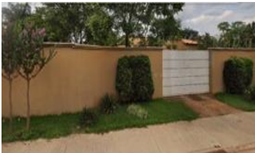
Foto 01 - Fachada Frontal do Imóvel contendo acesso pavimentado em asfalto, com muro, calçadas pavimentadas, com portão metálico, pintura em bom estado de conservação.
