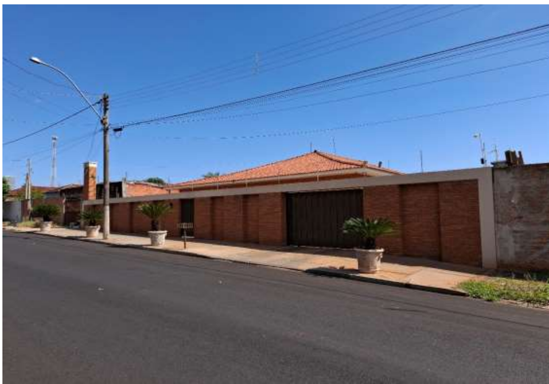
Foto Nº 01: Mostrando a frente do imóvel da Rua Trinta de Dezembro, 166
