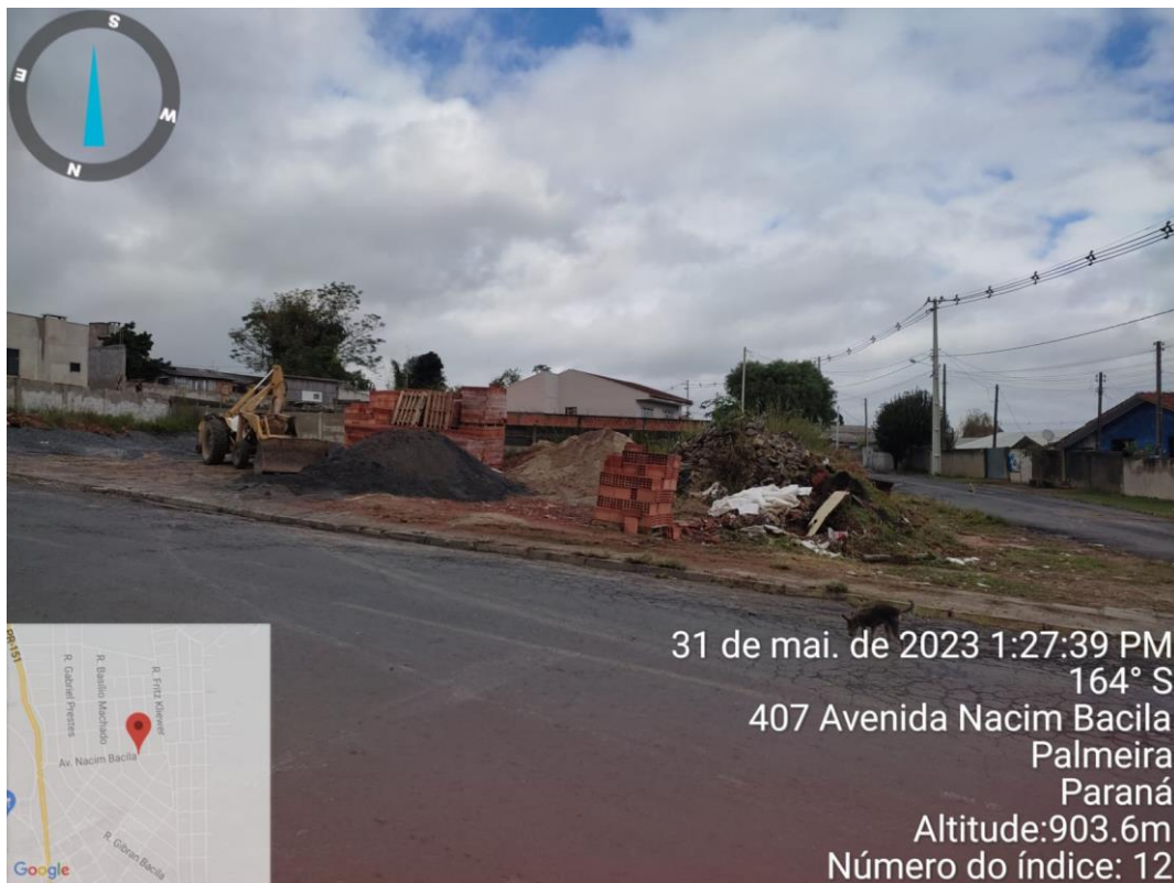
Imagem 5: Vista frontal do imóvel
