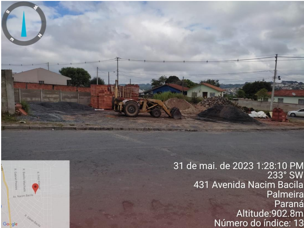
Imagem 2: Vista frontal do imóvel
