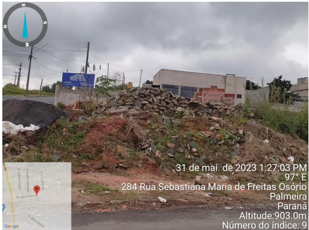
Imagem 3: Vista interna do imóvel
