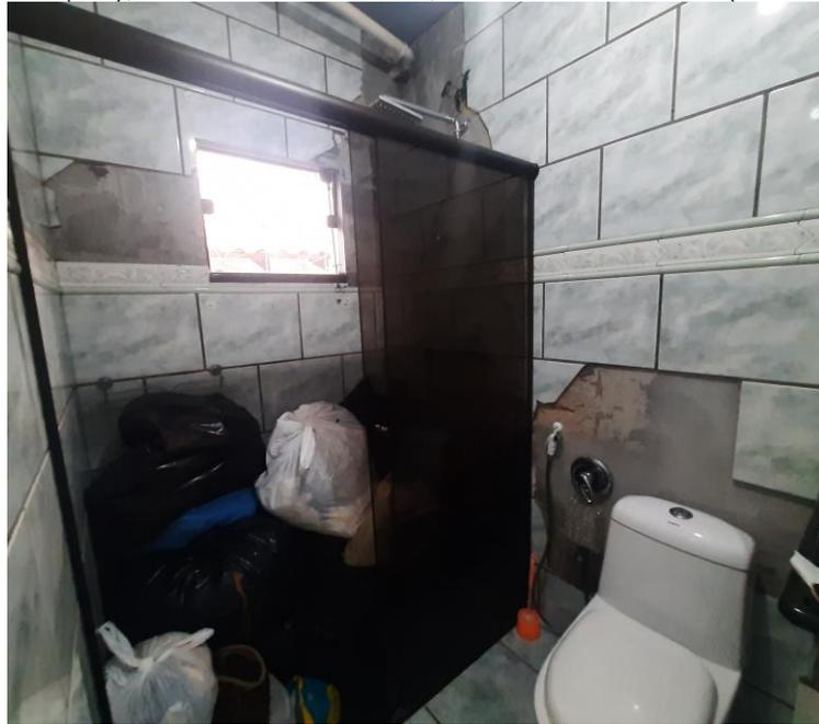
Banheiro suíte, possui azulejos com avarias e tubulação do 2 Pavimento aparente. 1 Pavimento.
