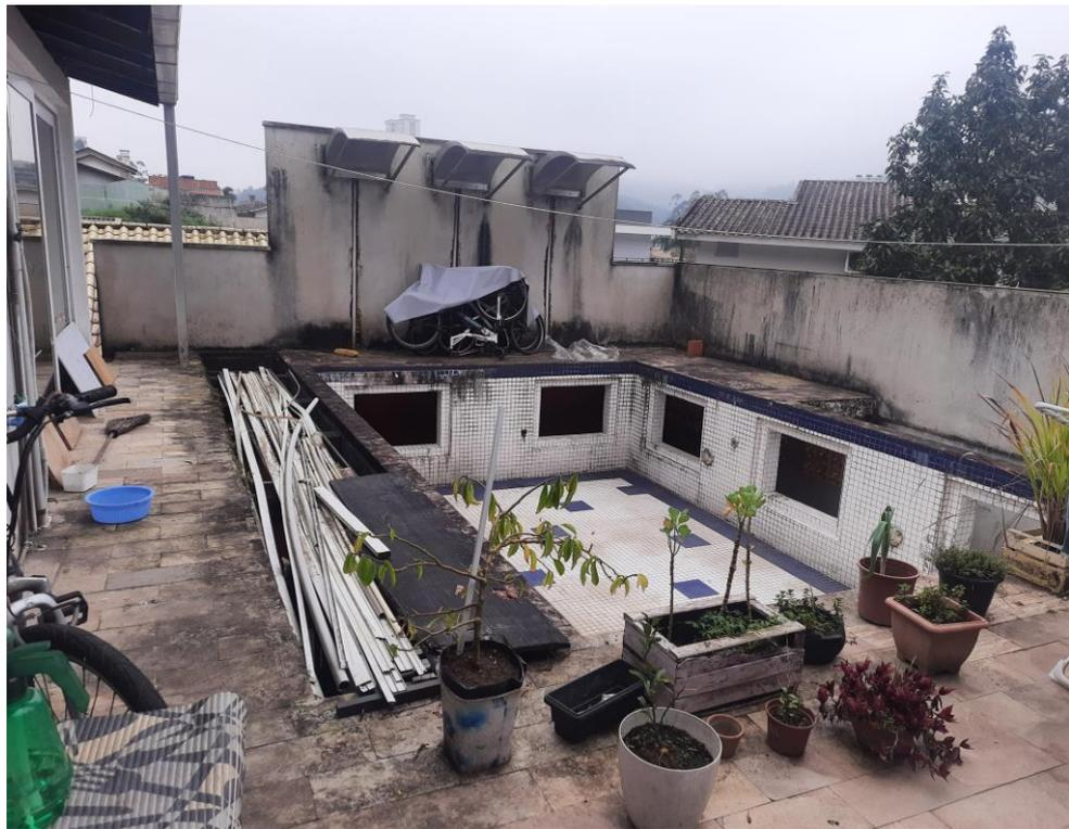
Área Piscina – Fundos do Segundo Pavimento – Vista lateral esquerda / fundos. Piscina de alvenaria aproximadamente 24m<sup>2</sup> e paredes externas faltam acabamentos e pintura.
