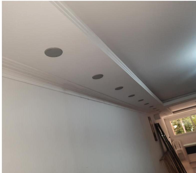
Acabamentos da sanca aberta e rebaixo em gesso acartonado drywall com espera para iluminação (Sala de estar e sala de jantar). 2 Pavimento.
