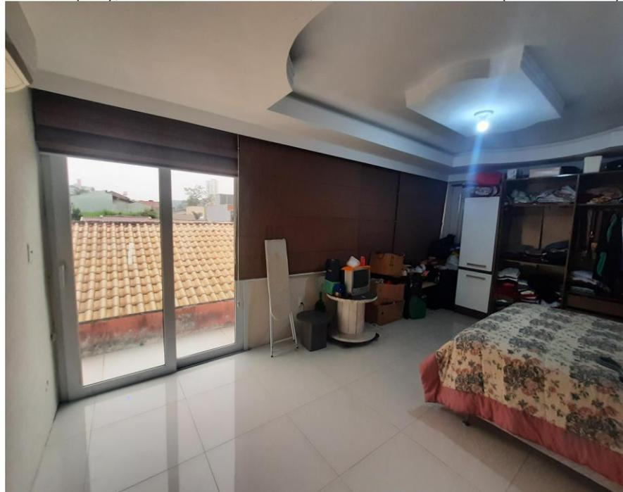
Dormitório 2 – Piso porcelanato 60x60, sanca aberta e rebaixo em gesso acartonado drywall, porta de entrada ao dormitório 2 em madeira e 1 porta de correr em alumínio anodizados com vidros em blindex (Saída lateral direita da varanda). 2 Pavimento.
