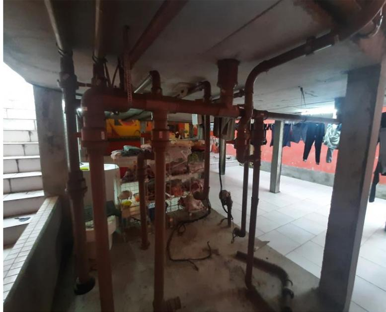
Fundos do terreno. Fundamento para sustentação da piscina, esperas e encanamentos prontos para sala de máquinas. 1 Pavimento.
