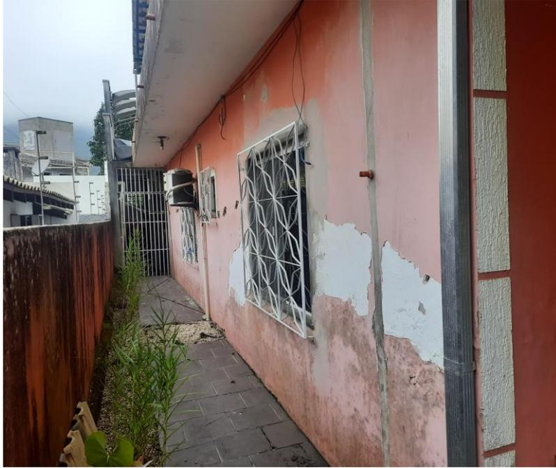
Parede lateral direita do imóvel (Possui Infiltração e pintura em desgaste).
