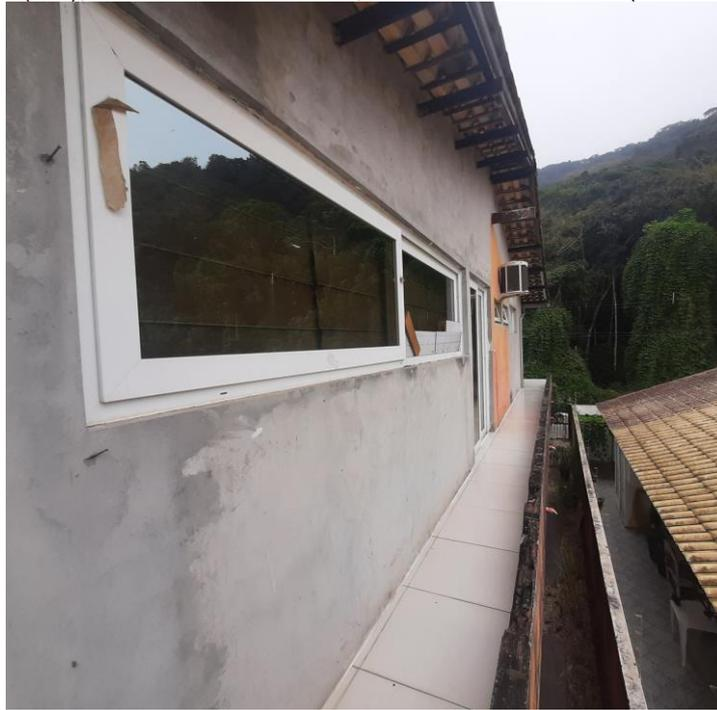
Fundos do 2 Pavimento – Vista lateral Direita / Frente. Paredes externas (faltam acabamentos e pintura). 1 porta de correr em alumínio anodizados e janelas com vidros em blindex (acesso ao dormitório 02). Sacada lateral direita não possui grades de proteção.
