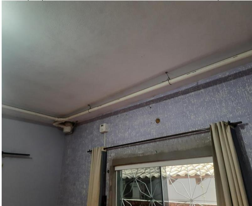
Dormitório 1 (Suíte), tubulação do 2 pavimento aparente. 1 Pavimento.
