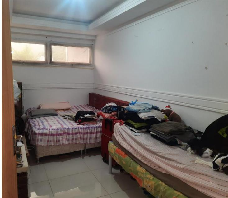
Dormitório 1 – Piso porcelanato 60x60, sanca aberta e rebaixo em gesso acartonado drywall, portas em madeira e esquadrias em alumínio anodizados com vidros em blindex. 2 Pavimento.
