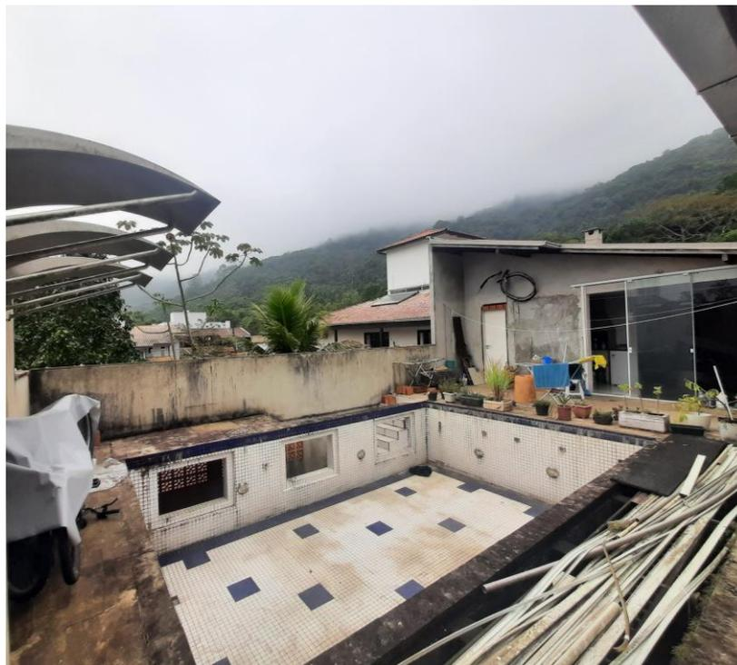
Área Piscina – Fundos do 2 Pavimento – Vista lateral Direita / Fundos. Piscina de alvenaria e paredes externas (faltam acabamentos e pintura). Porta em madeira / acesso ao banheiro social - 1 porta de correr em alumínio anodizados com vidros em blindex (acesso a cozinha).
