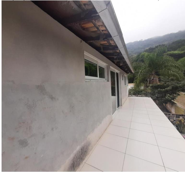
1 sacada de 2x12 metros (24m<sup>2</sup>) com piso porcelanato 60x60, esquadrias em alumínio anodizados, vidros em blindex, paredes externas (faltam acabamentos e pintura), sacada frontal não possui grades de proteção. 2 Pavimento.
