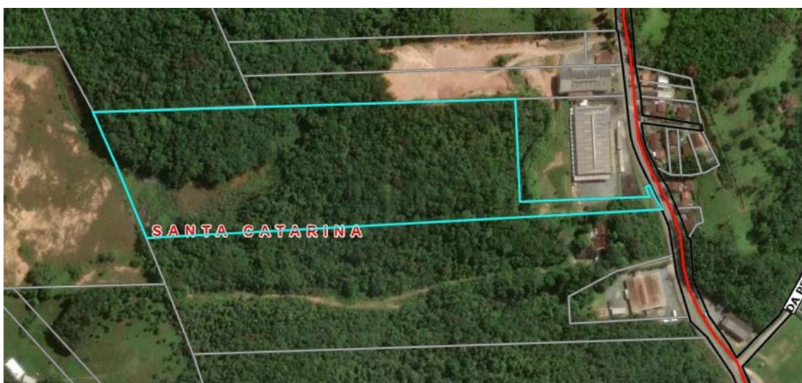
FOTO 01 – FOTO AÉREA INDICANDO O IMÓVEL AVALIANDO – Fonte: Google Earth
